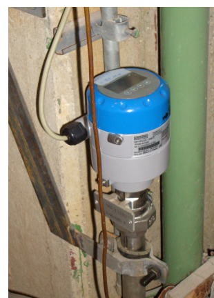
OPTIFLEX 1100 с укороченным технологическим присоединением
