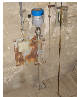
Монтаж на успокоительной трубе
