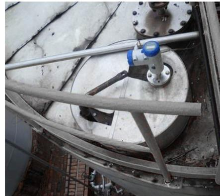
An Tankstutzen montierter OPTIWAVE 5200 Ex d ia
