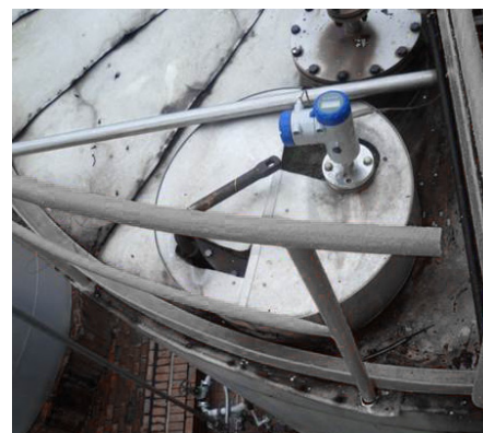
OPTIWAVE 5200 Ex d ia monté sur un piquage de réservoir
