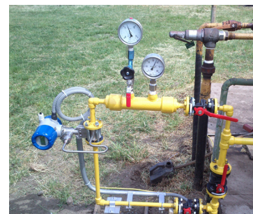
Монтаж расходомера с присоединением типа "сэндвич"
