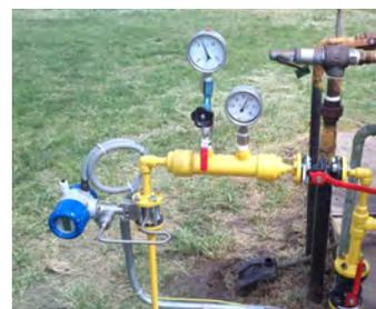
Montage de débitmètre à raccordement sandwich
