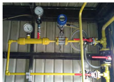
Débitmètre vortex monté dans une conduite de dérivation
