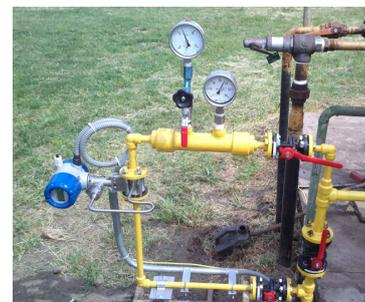
Installation eines Durchflussmessgeräts mit Sandwich-Anschluss
