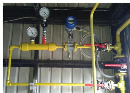
Wirbelfrequenz-Durchflussmessgerät in einer Bypass-Leitung
