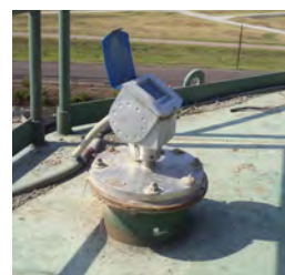
OPTIWAVE 6300 C на резервуаре с зольной пылью
