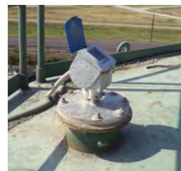
El OPTIWAVE 6300 C en un silo de cenizas volantes
