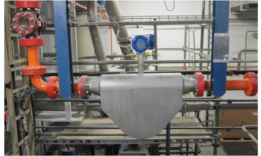
Carga para la transferencia de custodia con el OPTIMASS 6400 C
