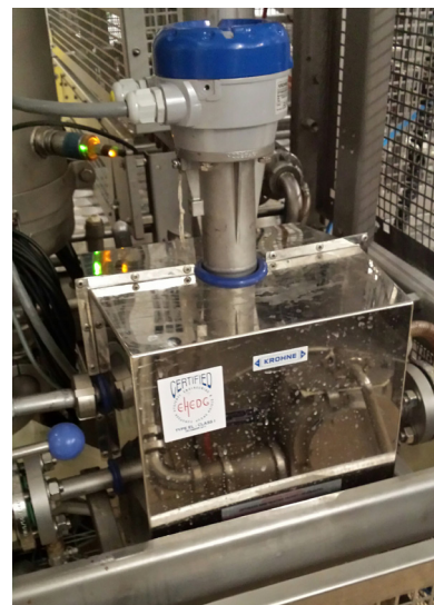
Dosage du chocolat liquide avec l'OPTIMASS 6400 (avec enveloppe de réchauffage)
