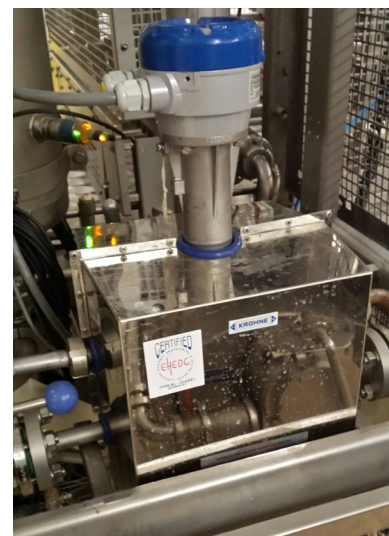
Dosificación de chocolate líquido con el OPTIMASS 6400 (con camisa de calefacción)
