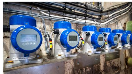
Füllstandmessgeräte mit geführtem Radar (TDR) vom Typ OPTIFLEX 2200
