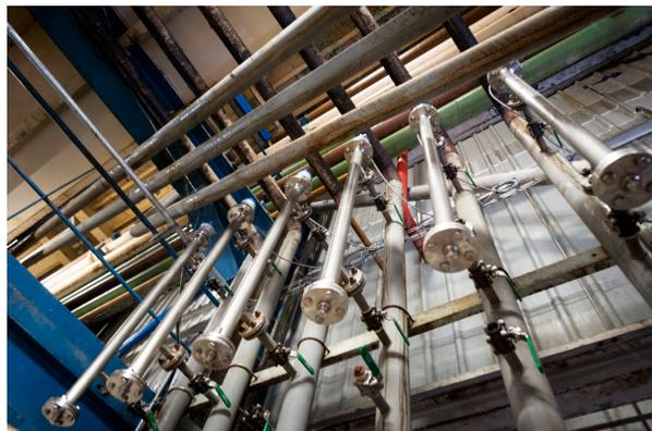
Les OPTIFLEX 2200 mesurent le niveau de retour de condensats
