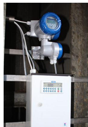
Messumformer (Feldgehäuse) des OPTIMASS 1400 F oben, Vorwahlzähler unten
