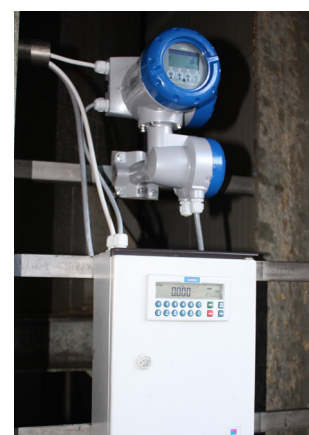
Convertisseur de mesure (boîtier intempéries) de l'OPTIMASS 1400 F en haut, compteur à présélection en bas
