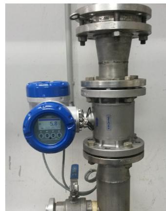
Durchflussmessung von Fett für die Pumpensteuerung
