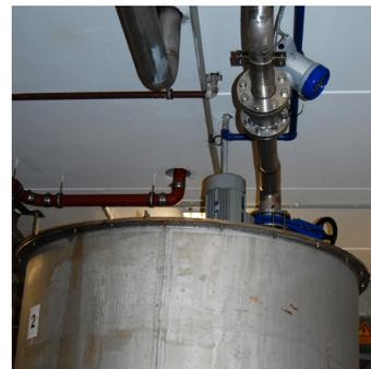
Installation des OPTIFLUX 7300 C zu Abrechnungszwecken
