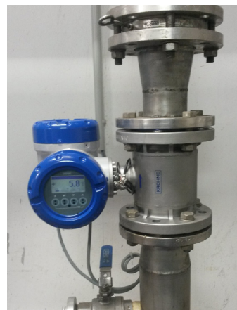
Измерение расхода жира при управлении насосом
