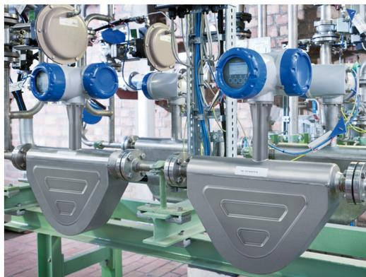
Équipements de sécurité intégrés au système de commande du process avec OPTIMASS 6400 installé en série
