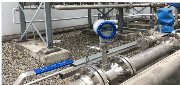
OPTISWIRL 4200 mit integrierter Druck- und Temperaturkompensation
