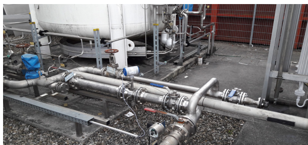
Mesure d'azote après un tranquilliseur d'écoulement intégré
