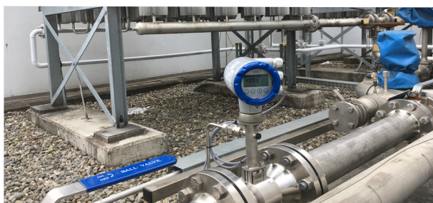
OPTISWIRL 4200 avec compensation intégrée de la pression et de la température
