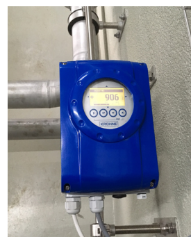
Измерение флокулянтов с OPTIFLUX 1050
