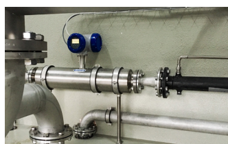
Позиция измерения с OPTIMASS 7400 C
