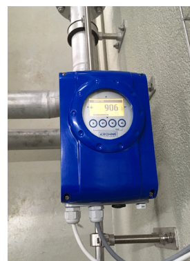
Medida de floculantes con el OPTIFLUX 1050
