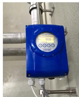
Mesure de floculants avec l'OPTIFLUX 1050
