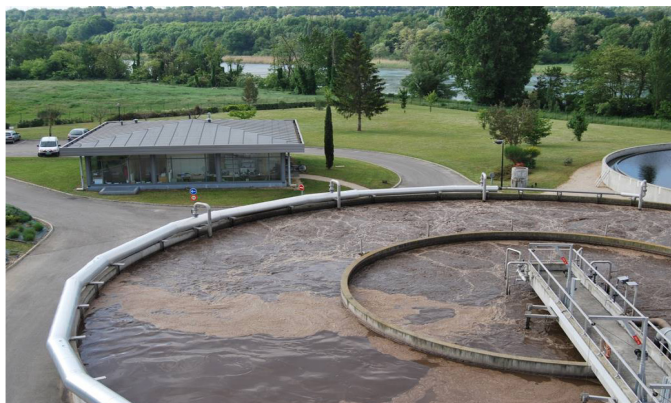
Станция очистки сточных вод
