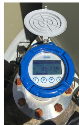
OPTIWAVE 6500 C installé au sommet du silo de chaux
