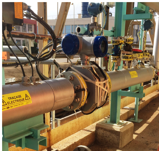
Comptage transactions commerciales avec le débitmètre à ultrasons ALTOSONIC V12
