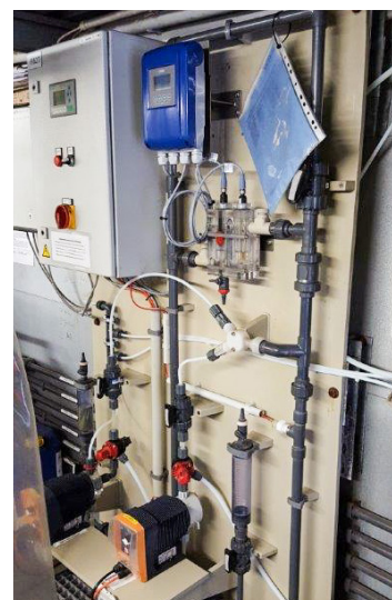
Überwachung von freiem Chlor durch den OPTISYS 1100
