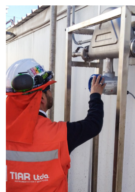
Montáž průtokoměru
