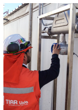
Montage du débitmètre
