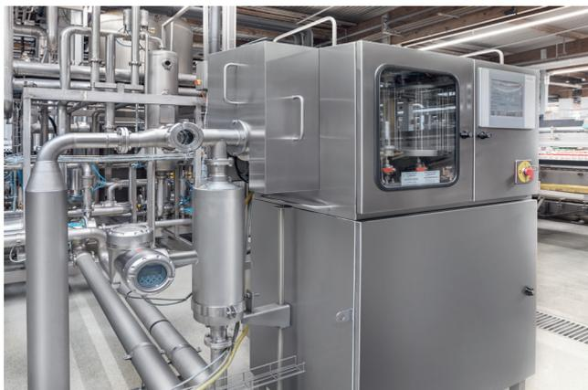
Durchflussmessung des Getränkevolumens mit dem OPTIMASS 1400 C
