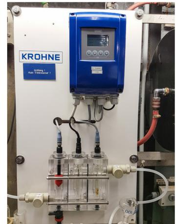
OPTISYS CL 1100 für die ph- und temperaturkompensierte Chlormessung
