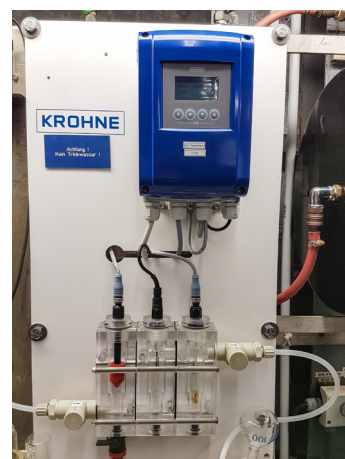
OPTISYS CL 1100 pro měření obsahu chloru s kompenzací na teplotu a pH
