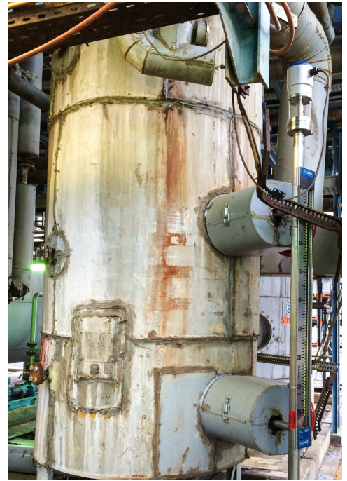
Bypass-Füllstandmessung von Dampfkondensat mit dem BM 26 W1010
