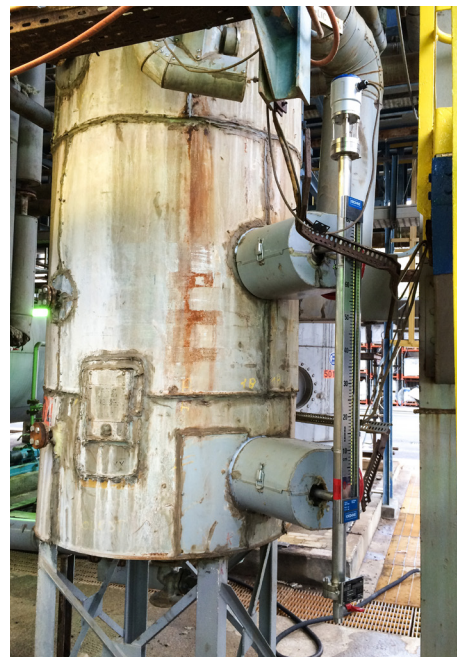
Байпасная технология для измерения уровня с BM 26 W1010, соединенным с резервуаром с пароконденсатом
