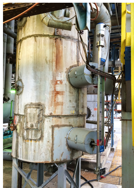
Mesure de niveau en dérivation avec le BM 26 W1010 raccordé au réservoir de condensats de vapeur
