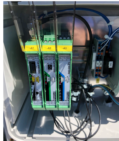
Modules sans fil et d'E/S pour l'unité de transmission KRL 70 sur le racloir
