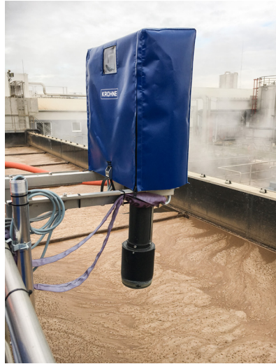
El OPTISYS SLM 2100 con cubierta protectora antihielo durante el funcionamiento en invierno
