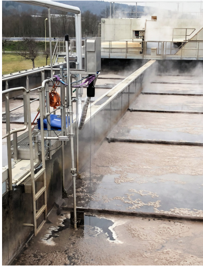
Medida del nivel de lodos en el clarificador
