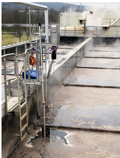
Měření rozhraní voda-kal v dosazovací nádrži
