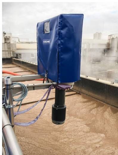
L'OPTISYS SLM 2100 avec couvercle de protection antigel en fonctionnement hivernal
