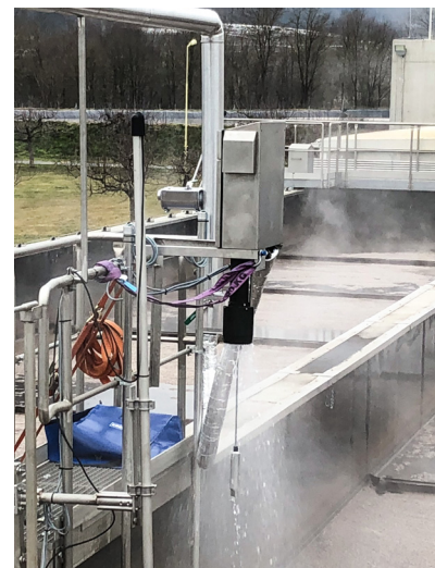
Système de nettoyage par rinçage intégré pour le capteur
