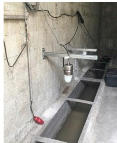
OPTIWAVE 1400 über dem offenen Kanal montiert
