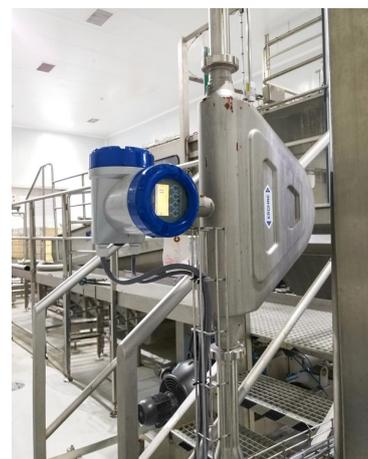
Durchflussmessung von Tomatenmark mit dem OPTIMASS 6400
