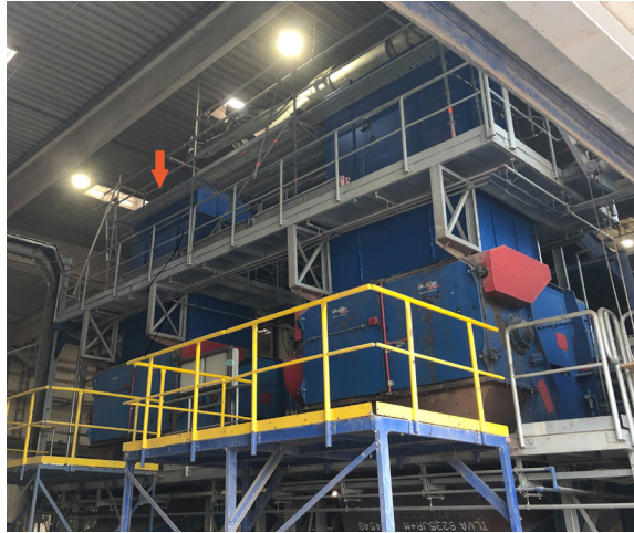
Müllcontainer mit der Messstelle des OPTIWAVE 6500 (roter Pfeil)
