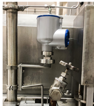
OPTIWAVE 3500 über dem Frittierbehälter montiert
