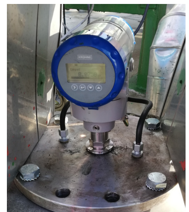
OPTIFLEX 7200 auf dem Tankstutzen
