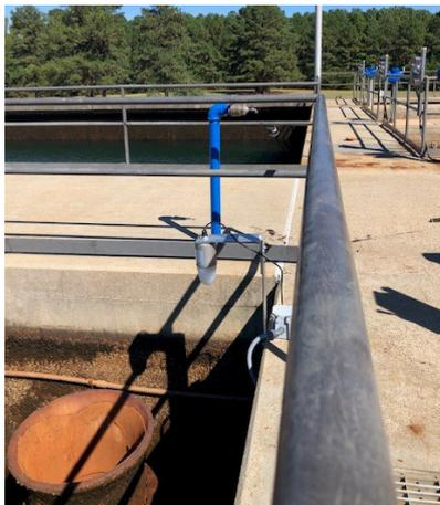
Radar-Füllstandmessung von Wasserbecken
