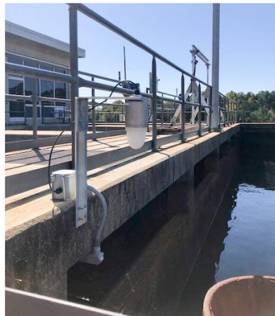
FMCW-Radar in der Nähes des Überlaufrohrs installiert
