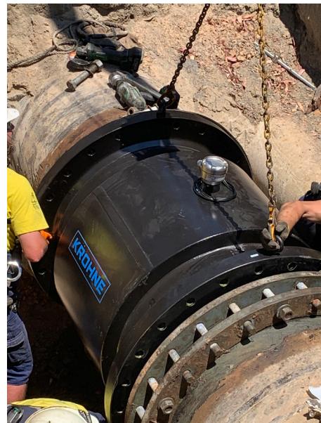
OPTIFLUX 2300 W mit Spezial-Beschichtung für den Erdeinbau
