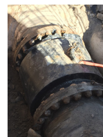
Beschädigtes MID vor dem Austausch des Spulenraums
