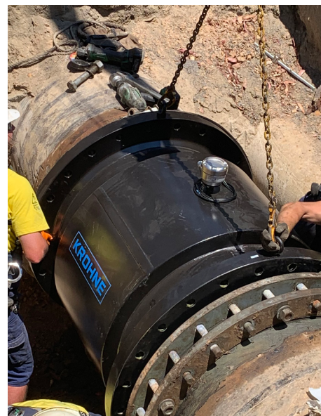
OPTIFLUX 2300 W со специальным покрытием для установки под землей
