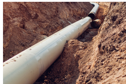
Bau einer Pipeline
