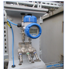
Platzsparender Differenzdrucktransmitter OPTIBAR DP 7060 in Druckstufe PN700
