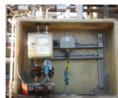
Alter Differenzdrucktransmitter vor dem Austausch
