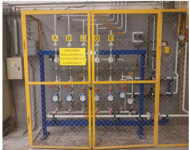
Versorgungsleitungen für Schwefeldioxid und Stickstoff mit Schwebekörper-Durchflussmessgeräten
