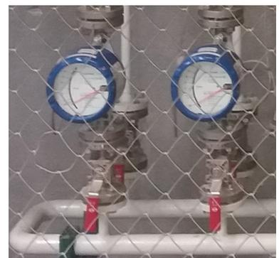
Durchflussmessung von Schwefeldioxid mit H250 M40
